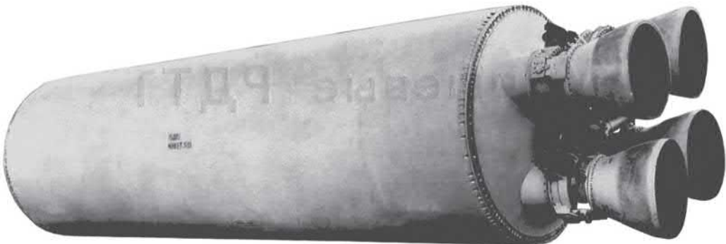
Перший твердопаливний двигун 15Д15 для першого ступеня МБР РТ-20П
